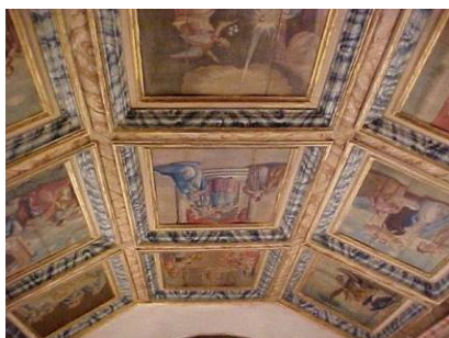
Foto 2 - Forro da capela mor (após restauro) 1
