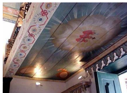
Foto 3 - Forro do átrio (após restauro)
